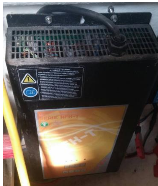
Slika (6.14.) – punjač baterija Atib – HF/Z, 50 A, 48 V, napajan iz krute mreže
